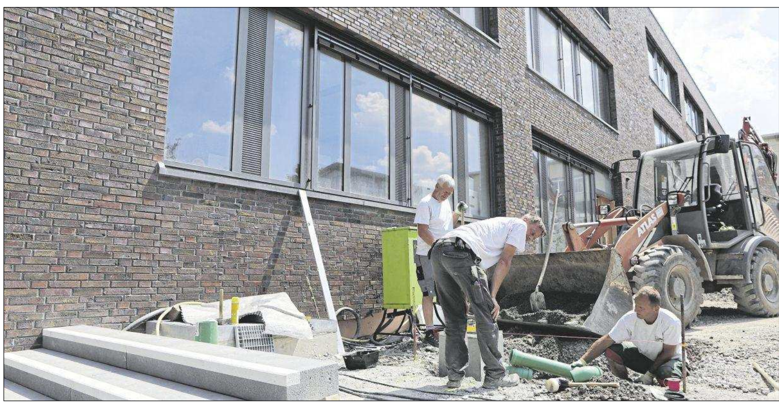
Nicht nur im Gebäude, sondern auch an allen Ecken und Enden ums Burg-Gymnasium herum wird derzeit gewerkelt und geschafft, damit alles rechtzeitig fertig wird.
